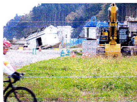
基礎ごと流されて傾いた コンクリート施設
